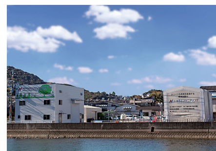
本社事務所・工場
