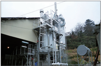
燃 焼 物:ブロイラー鶏糞 燃焼能力:75kg/Hr
